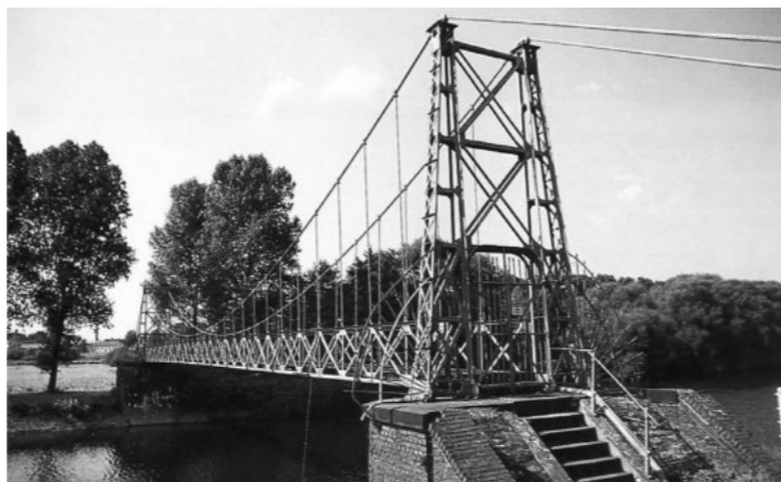
(4) Seilhängebrücke am Kaltenborn (Foto W. Schöne)
